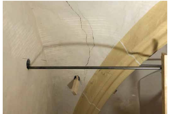
Risse im Gewölbe | Cracks in the vault
