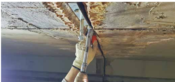
Einbau und Befestigung des DESOI Quick Seal Installation and fastening of the DESOI Quick Seal
