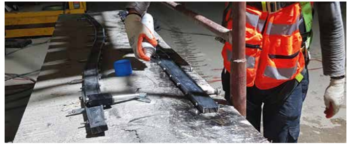
Auftragen des Schutzfilms mit Silikon-Spray | Application of the protective film with silicone spray
