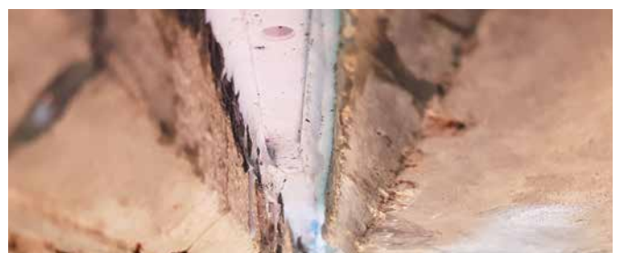
Erfolgreiche Injektion der Fuge | Successful injection of the joint
