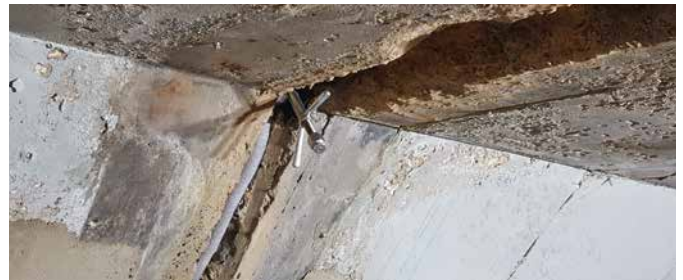
DESOI Quick Seal setzen, beginnend mit dem Rechteck-Stahlpacker Set DESOI Quick Seal, starting with the rectangular steel packer
