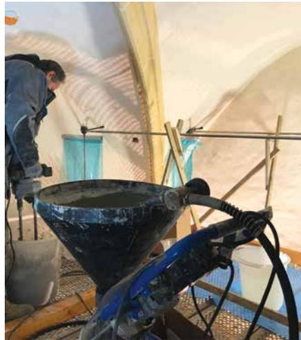
Anmischen des DESOI AnchorNox® Trockenmörtels vor der Injektion der Ankerstangen
